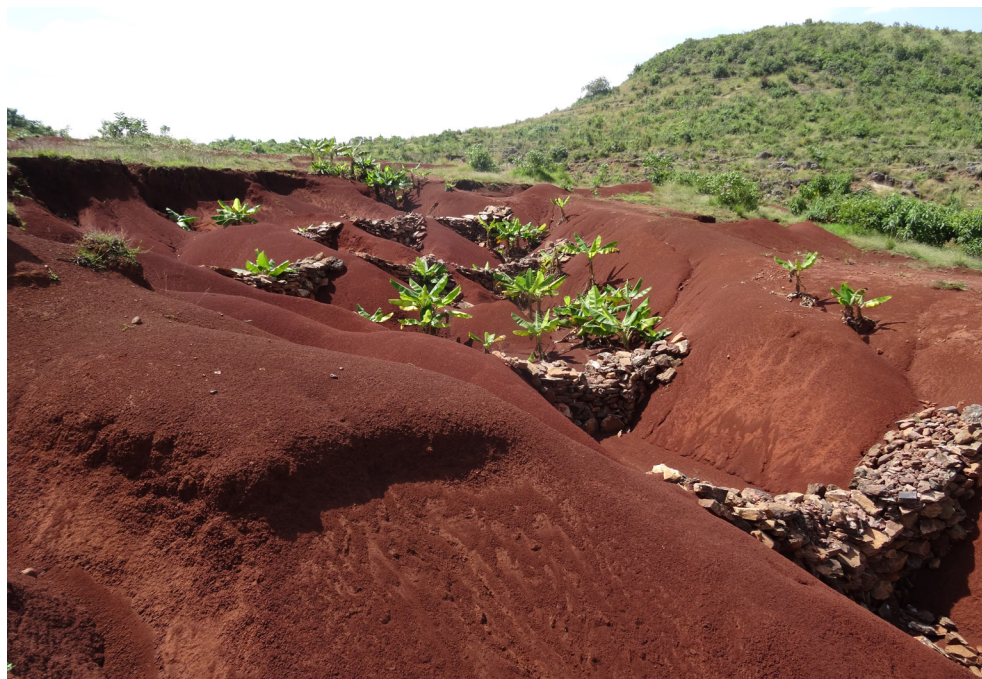
Начальный этап восстановления участка, пострадавшего от эрозии, Эфиопия
