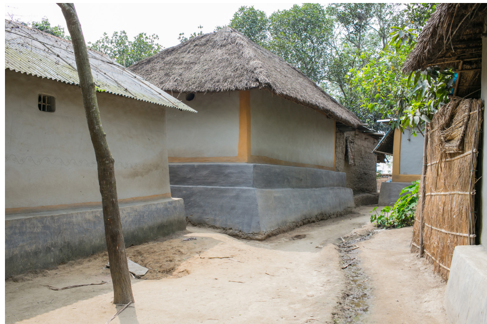
Защита домов от наводнений, Багладеш
