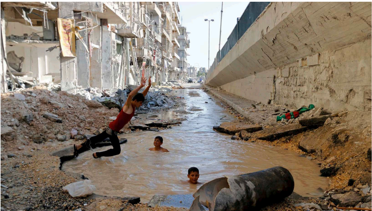
Eine zerstörte Wasserleitung in Aleppo, Syrien (© Reuters / Hosan Katan).
