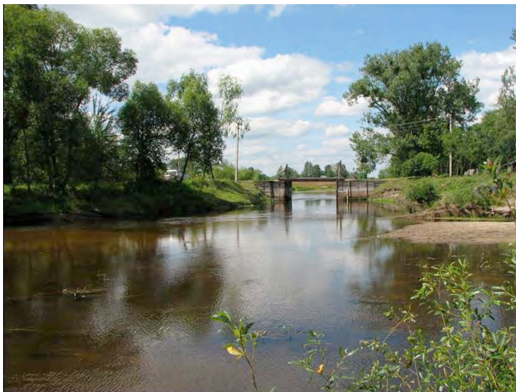
Рис. 4 – Выжевский водоспуск Белоозерской водопитающей системы Днепро-Бугского канала. Левый водоток – канал системы, правый водоток – р. Припять после отвода воды
