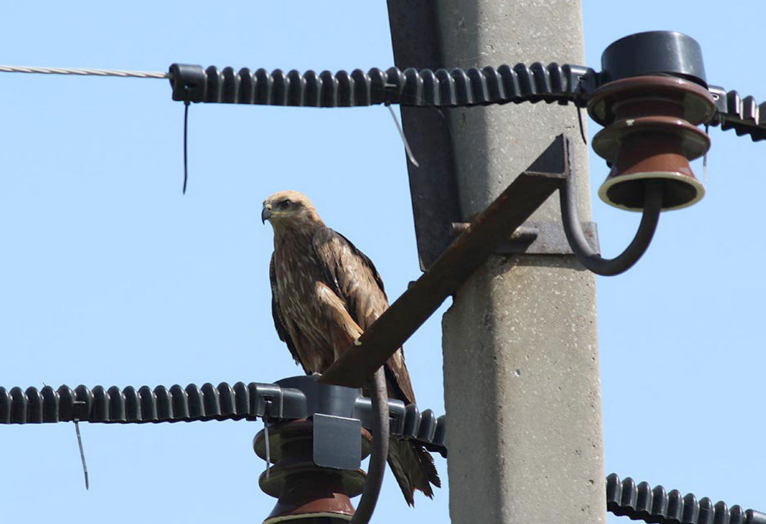
↑ Installing bird protection on power lines, Kazakhstan Установка защиты для птиц на линиях электропередач, Казахстан
